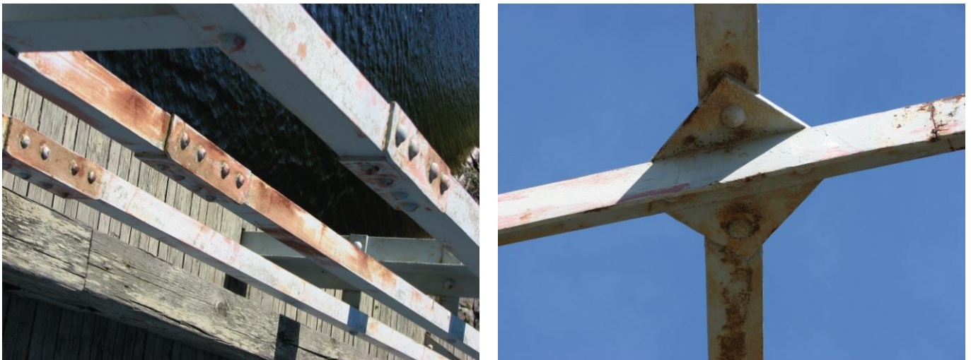
KUVA 2. Sillan teräskaiteet paikoin pahasti ruosteessa (maastotutkimus Kurkela 2007)
