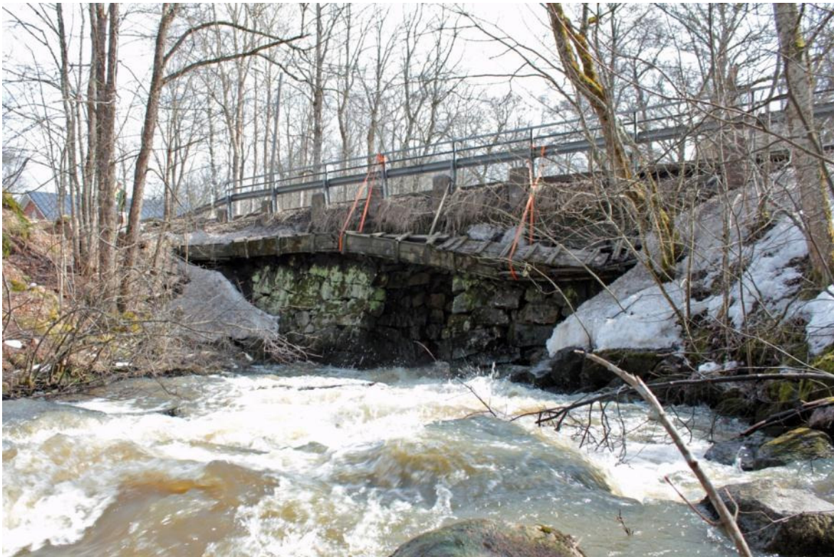
Sågbro yläjuoksulta kuvattuna. Kuvassa näkyy liinoilla kannateltu lahomut puinen kaapelikotelo, ja teräskaide. Teräskaitteen alapuolella erottuvat alkuperäiset kiviset kaidepilarit. Kuva Petra Kotro/Mobilia 12.4.2012.
