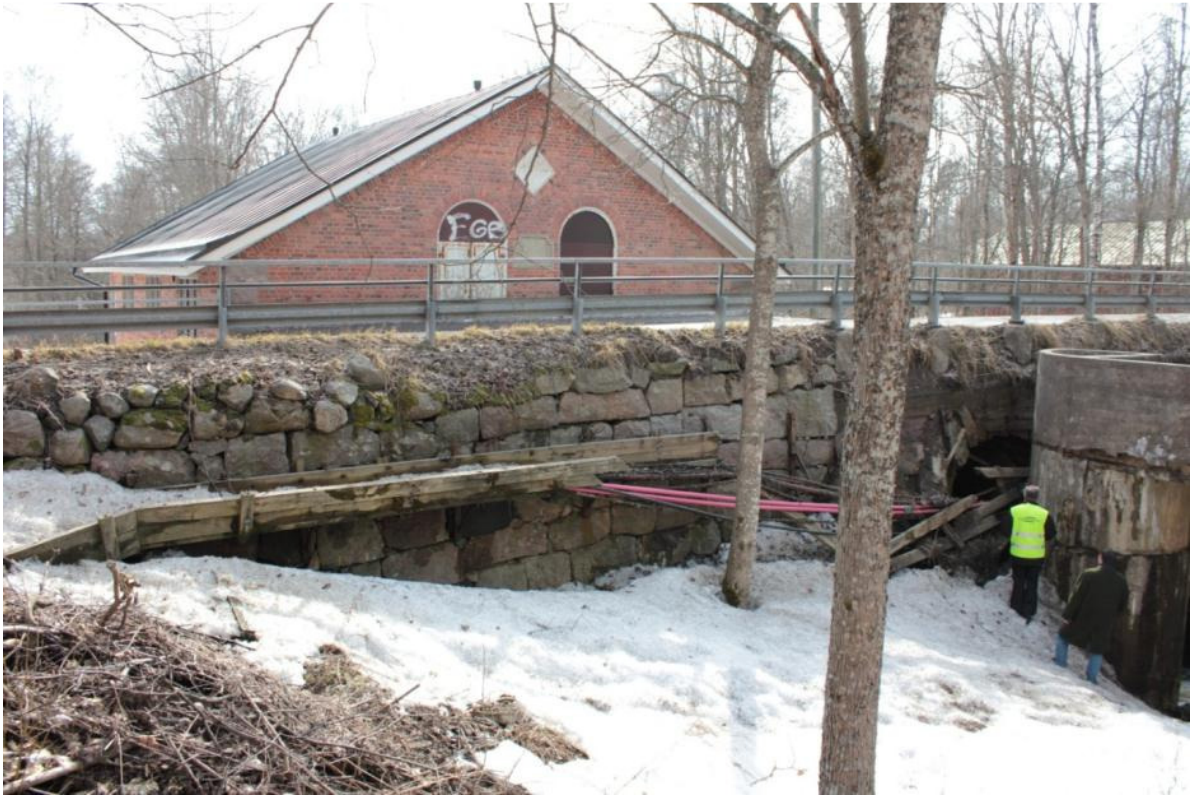
Qvarnbron siipimuuri Espoonkartanon päärakennukselta päin katsottuna. Taustalla myllyrakennus. Qvarnbron holviaukko jää betonisen vesikourun taakse. Kuvassa näkyvä siipimuuria on korjailtu jälkeensä, sillä näkyvät kivet on lohkottu ja ladottu eri tavalla kuin 1775-1777 rakennetuissa osissa, ja muuri nousee korkeammalle kuin alkuperäinen tien taso eli sillan kansi. Kuva Petra Kotro/Mobilia 12.4.2012.
