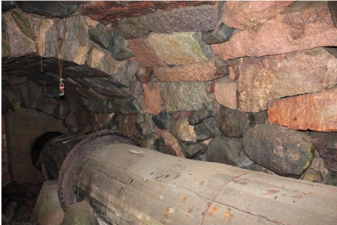
Qvarnbron kiviholvien alarakenne jatkuu yhtenäisenä myllyn seinälle saakka. Se on siis rakennettu ennen uudempaa, matalaa kiviholvia. Kuva Petra Kotro/Mobilia 26.4.2012.
