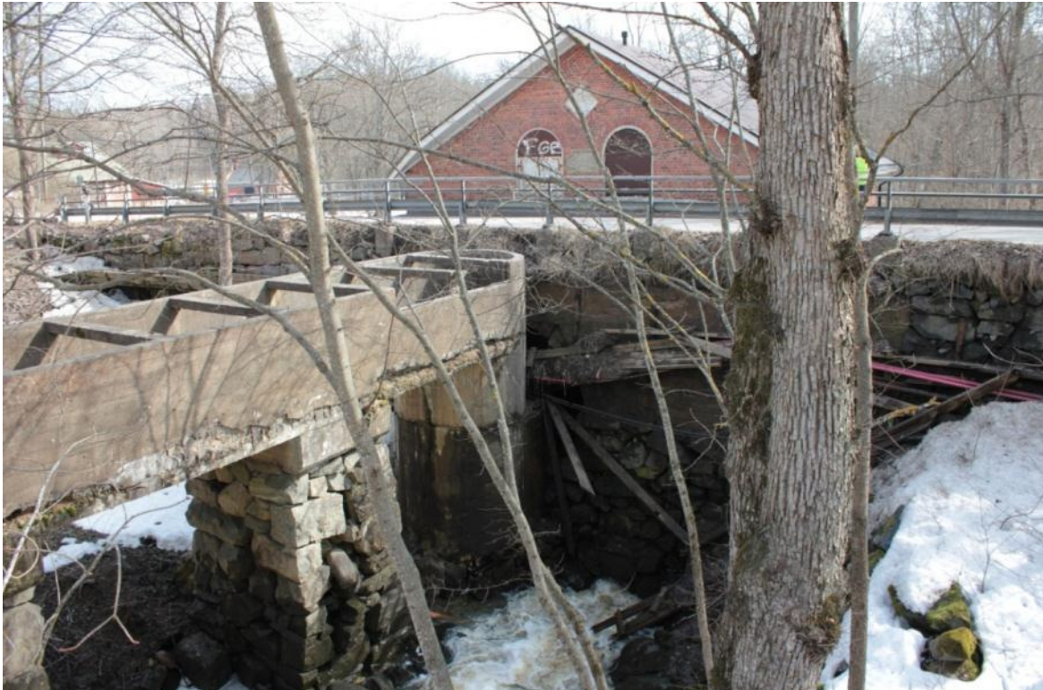
Qvarnbron kiviholvi jää piiloon betonisen, kiviPilareilla seisovan vesikourun taakse. Taustalla näkyy sillan toisella puolella sijaitsevan myllyrakennuksen ylin, punatiilestä rakennettu kerros. Kuvan alareunassa virtaava vesi kulkee sillan ali pientä ohjuksutuskanavaa pitkin. Kuva Petra Kotro/Mobilia 12.4.2012.
