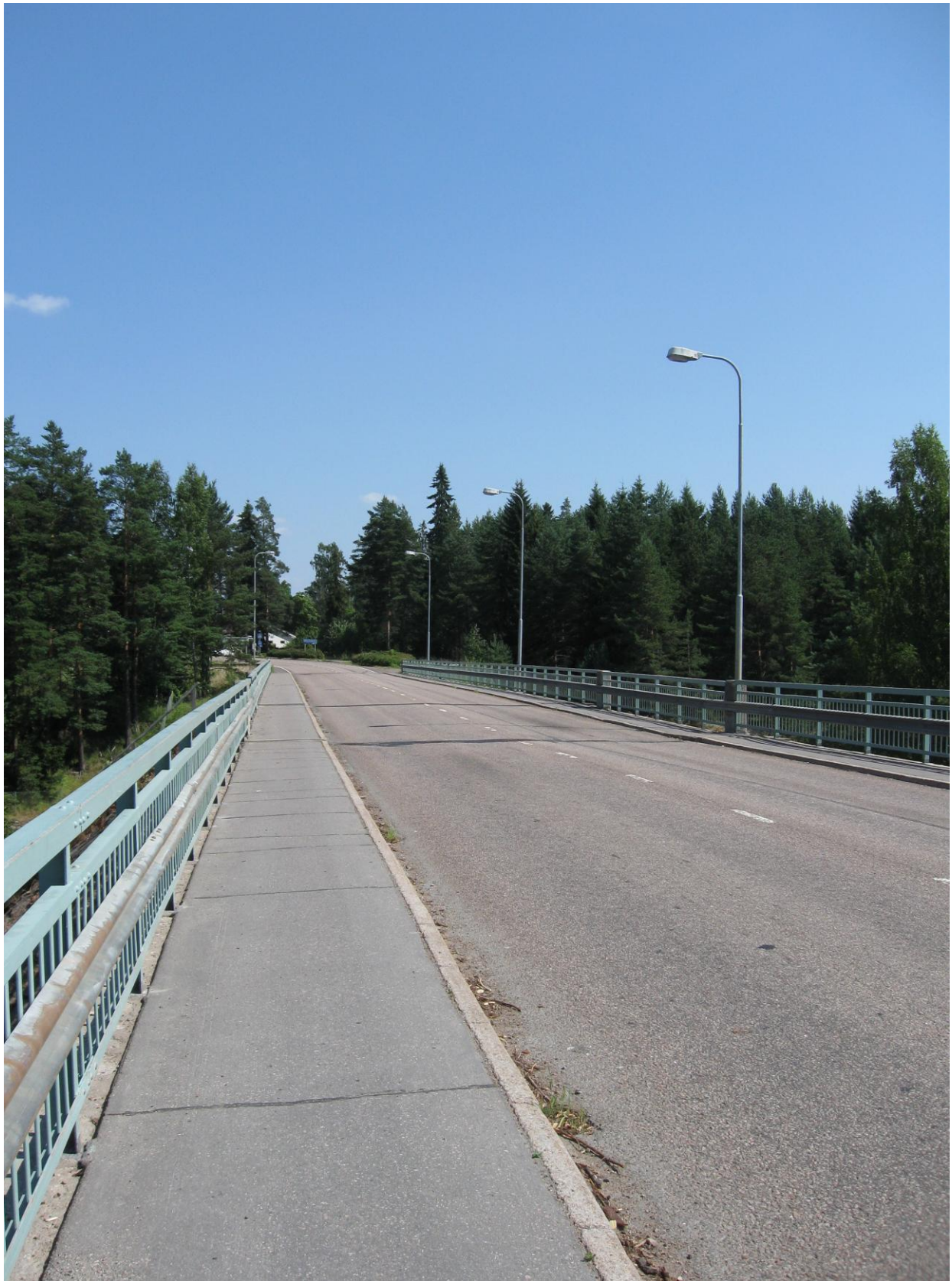
Keskikosken sillan päällysrakenne Ummeljoen puolelta kuvattuna. Huomaa jalkakäytävän kapeus.
