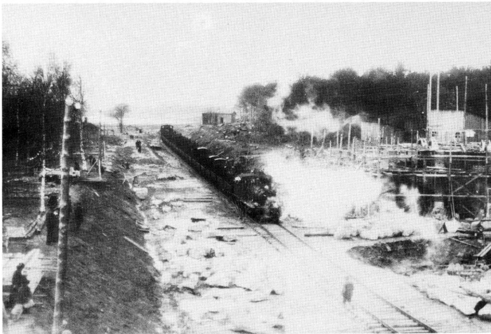
Rautatien kiskotus saavutti Kristiinankaupungin toukokuussa 1912. Kuvassa kiskotus on rakenteilla ja junan oikealla puolella erottuvat kääntöpöydän ja veturitallin työmaat. Kuva on otettu uudelta ratapihasillalta. Kuva: Kopio: Kristinestad -en småstadsidyll, s. 115.
